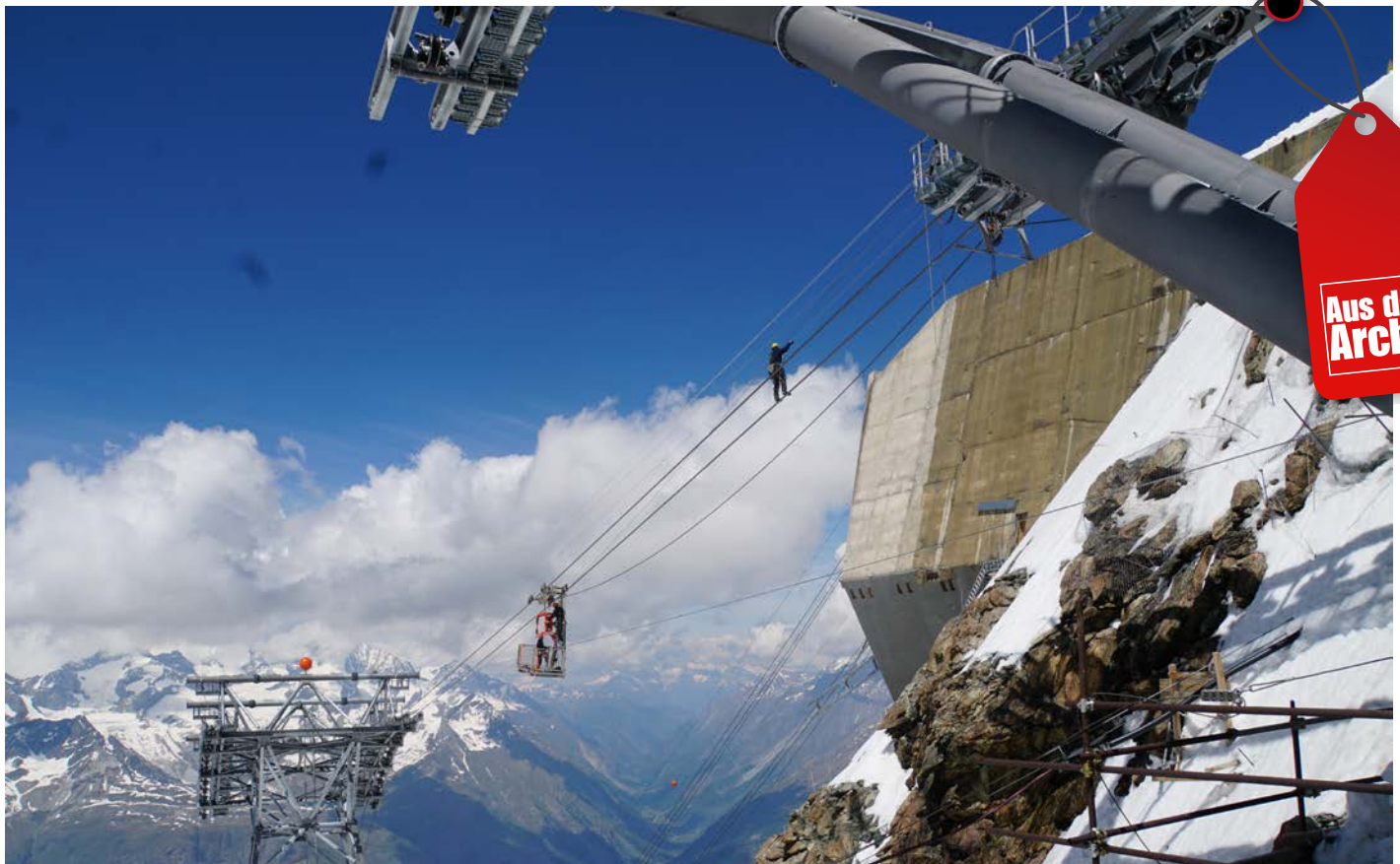
Bei der Bergstation Klein Matterhorn fixieren Monteure die Seilreiter der 3S-Umlaufbahn.
